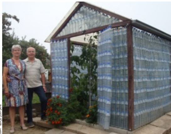
Willy et Claudine ont construit une serre sur la base d'un matériau de récupération : des bouteilles en plastique.
